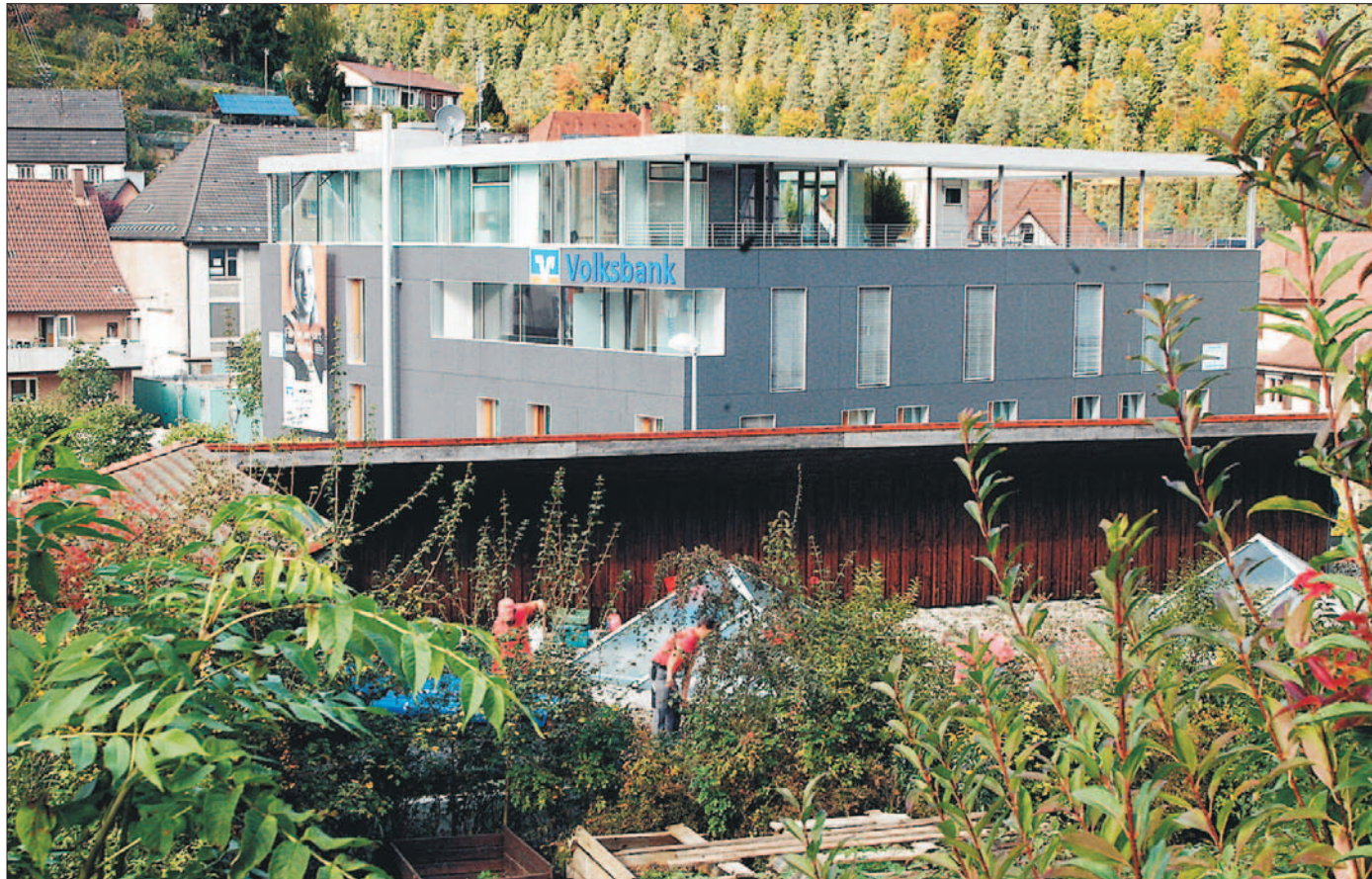
Aus dieser eher ungewöhnlichen Perspektive haben bislang die Oberndorfer das Dach ihres Parkhauses wohl kaum wahrgenommen, zumindest nicht bewusst. Derzeit sind Mitarbeiter der Firma Lange dabei, das teilweise undichte Dach abzudichten. Foto: Wolf
