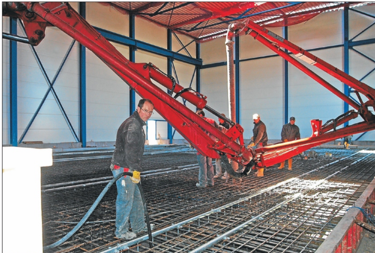
Unwahrscheinliche Mengen von Beton müssen in das mächtige Fundament der neuen ITS-Montagehalle im Industriegebiet »Rankäcker« fließen, damit die ausreichende Festigkeit und Steifigkeit für die Montage von Großmessmaschinen erreicht wird. Fotos: Wolf
